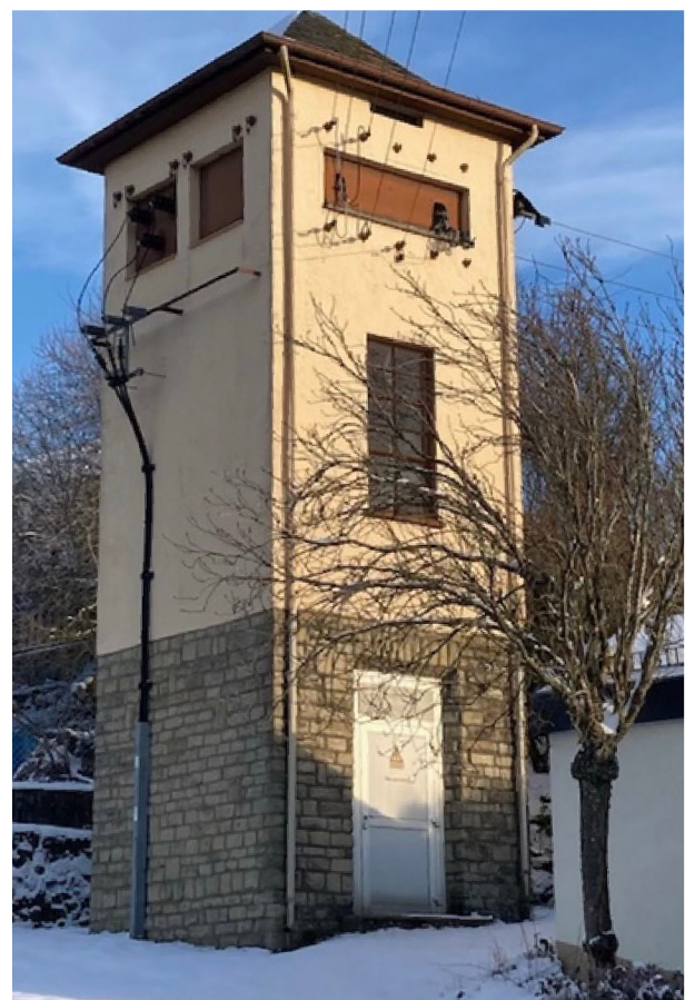
Trafogebäude am Feuerwehrgerätehaus
